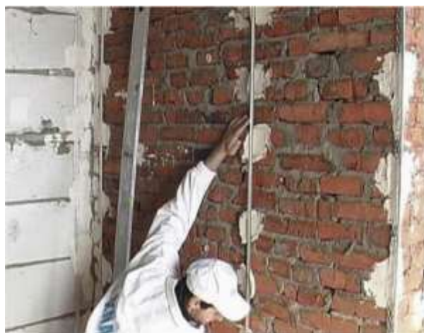
Рисунок 1 –Установка перфорированных маяков
